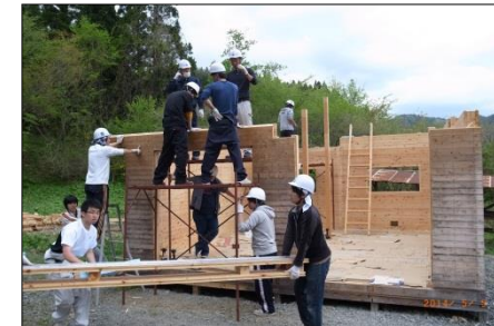
泊区仮設公民館の解体 結っ小屋としての再建
